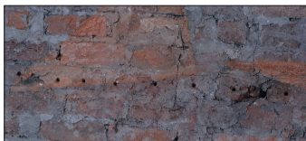
Fragment Ściany Północnej, który został poddany osuszeniu poprzez zrobienie drenażu, a następnie oczyszczeniu starego fresku. Prace wykonane zostały w październiku 2009. Detail of the Northern Wall which has been dried by drainage and the old frescoes cleaned afterwards. The work was completed in October 2009.
